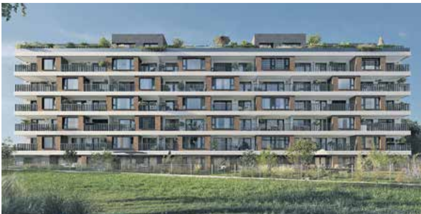
Na podzim roku 2023 v Praze začne výstavba bytového domu Letnians s unikátním programem financování BYX.
