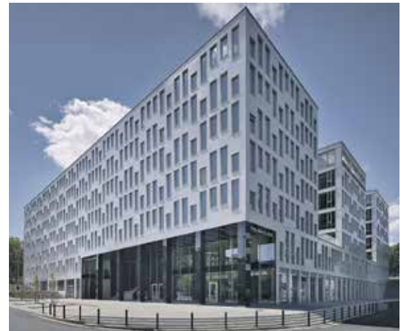
Telehouse Office Park Praha je od roku 2022 sídlo pražské pobočky SYNER.
